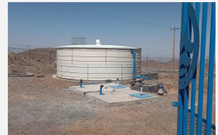
پروژه آب و فاضلاب اصفهان - شیرازان - اردستان - ۱۱۶ مترمکعب Project of Water & Sewerage of Isfahan - Shirazan - Ardestan - 116 m 3
