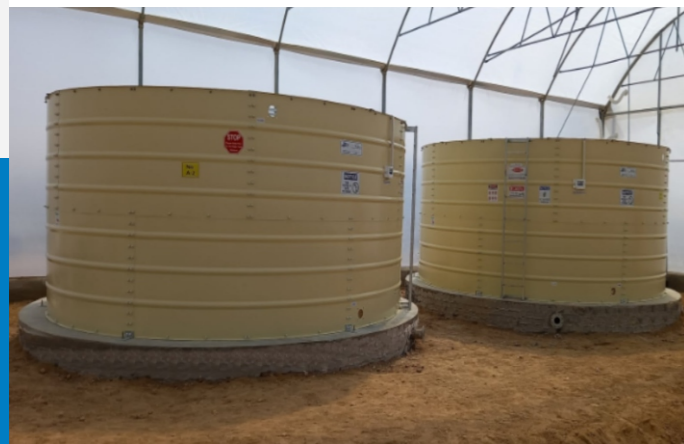
پروژه گلخانه - نهاوند - همدان - ۱۰۰ مترمکعب Project of Greenhouse - Nahavand - Hamadan - 100 m 3
