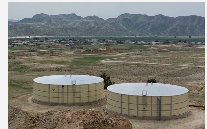
پروژه میداوود - باغملک - خوزستان - ۱۰۰۰ مترمکعب Project of Meydavoud - Bagh-e malek - Khuzestan - 1000 m 3
