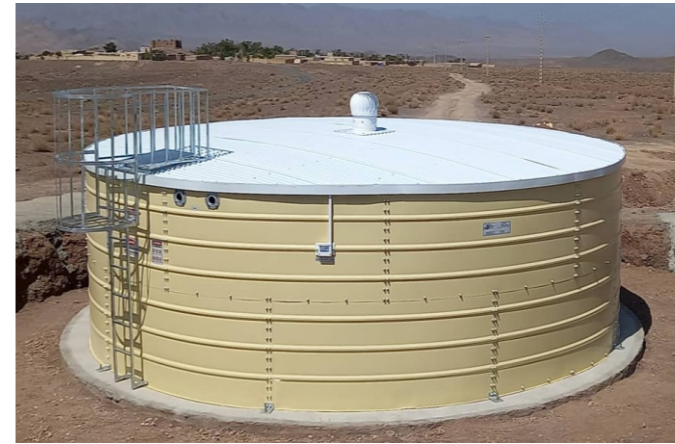
پروژه میشاب - اردستان - اصفهان - ۱۰۰ مترمکعب Project of Mishab - Ardestan - Isfahan - 100 m 3
