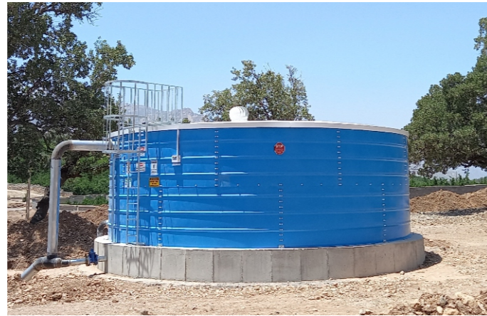
پروژه آب و فاضلاب شیراز - فتح آباد علیا - شیراز - ۱۰۰ مترمکعب Project of Water & Sewerage of Shiraz - Fath Abad Olia - 100 m 3
