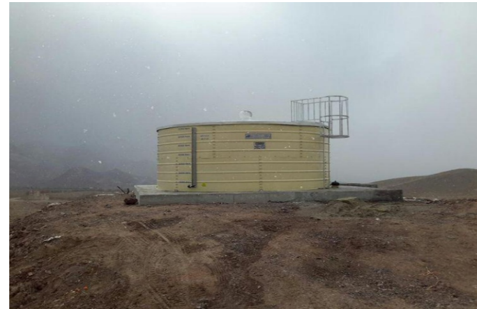
پروژه آب و فاضلاب اصفهان - کوهپایه - ۱۵۰ مترمکعب Project of Water and Sewerage of Isfahan - Kuhpayeh - 150 m 3
