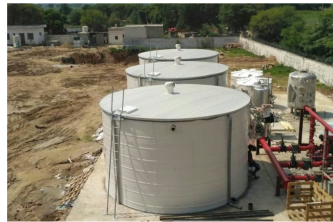
پروژه شهرک گلخانه ای - گیلان - ۲۰۰ مترمکعب Project of Greenhouse town - Gilan - 200 m 3
