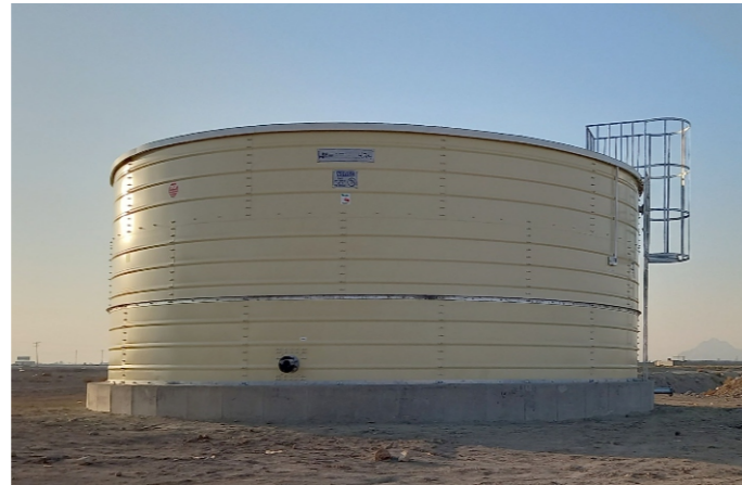
پروژه آب و فاضلاب اصفهان - هرمدان (کلودان) - ۳۰۰ مترمکعب Project of Water and Sewerage of Isfahan - hermedan - 300 m 3
