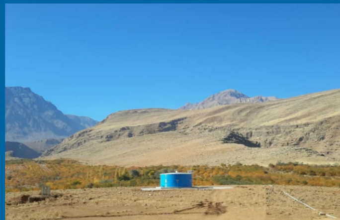
پروژه پادنا - سمیرم - اصفهان - ۲۰۰ مترمکعب Project of Padena - Semirom - Isfahan - 200 m 3
