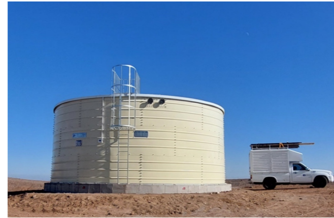
پروژه اردستان - اصفهان - ۲۰۰ مترمکعب Project of Ardestan- Isfahan - 200 m 3
