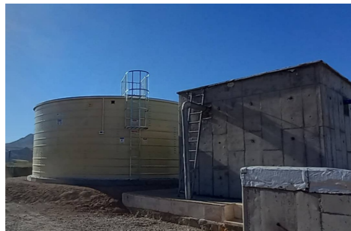
پروژه آب و فاضلاب اصفهان - کوهپایه - ۲۰۰ مترمکعب Project of Water & Severage of Isfahan - Kuhpayeh - 200 M 3
