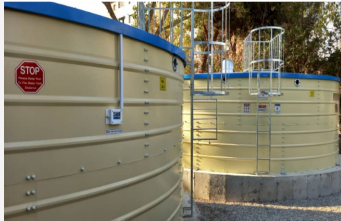
پروژه ستاد کل نیروهای مسلح - تهران - ۱۵۰ مترمکعب Project of General Staff of the Armed Forces - Tehran - 150 m 3
