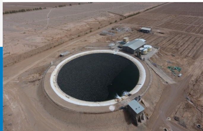
پروژه مرتاضیه - یزد - ۲۰۰ مترمکعب Project of Mortazieh - Yazd - 200 m 3
