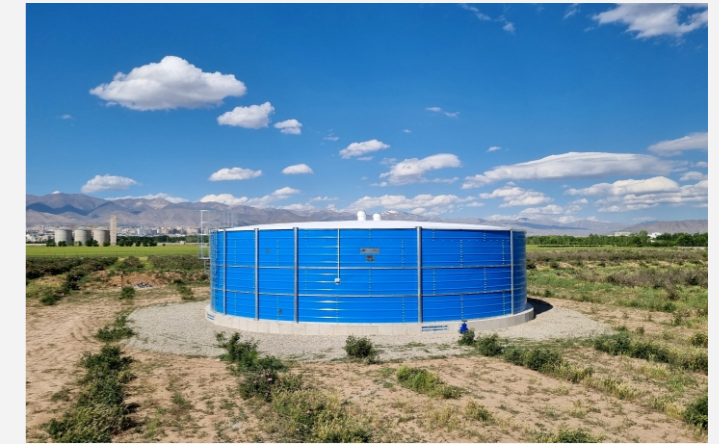
پروژه گلخانه هونام - هشتگرد - ۱۰۰۰ مترمکعب Project of Hounam Greenhouse - Hashtgerd - 1000 m 3
