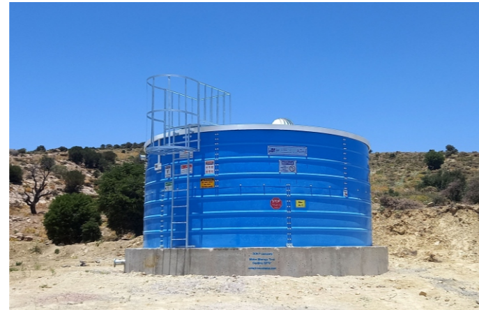
پروژه آب و فاضلاب شیراز - بیدقار - شیراز - ۵۰ مترمکعب Project of Water & Sewerage of Shiraz - Bidghatar - 50 m 3
