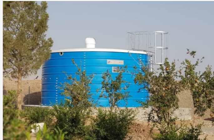
پروژه مهاباد - اردستان - اصفهان - ۵۲ مترمکعب Project of Mahabad - Ardestan - Isfahan - 52 m 3
