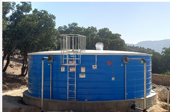
پروژه آب و فاضلاب شیراز - کوهمره سرخی - ۱۱۶ مترمکعب Project of Water & Sewerage of Shiraz - Kohmare Sorkhi - 116 M 3
