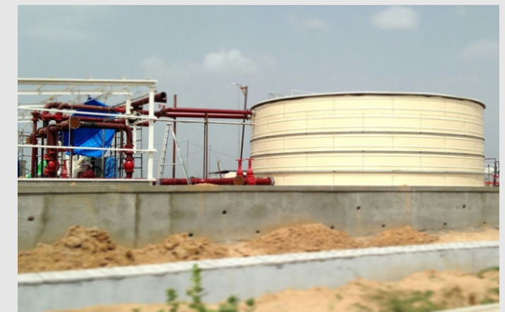
پروژه عسلویه - ۷۰۰ مترمکعب Project of Asaluyeh - 700 m 3
