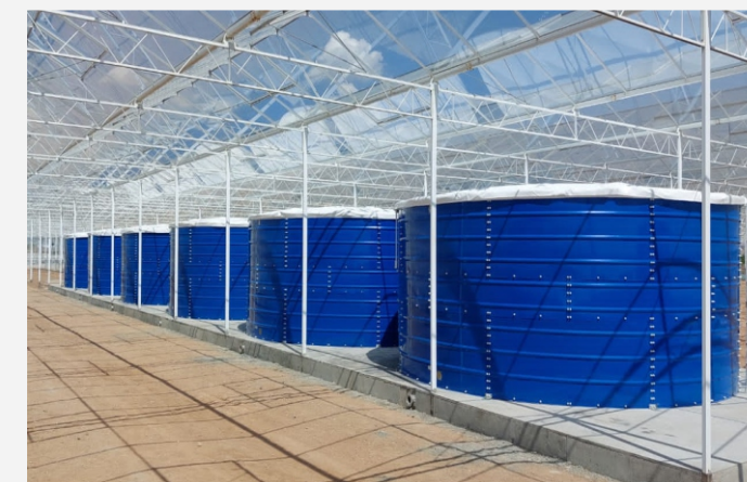
پروژه گلخانه - آبیک - قزوین - ۱۰۰ مترمکعب Project of Greenhouse - Abyek - Qazvin - 100 m 3
