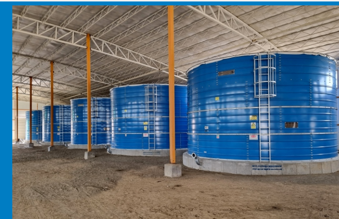
پروژه دیواندره - کردستان - ۲۰۰۰ مترمکعب Project of Divandarreh - Kurdistan - 2000 m 3
