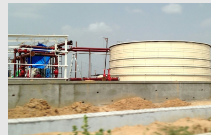
پروژه عسلویه - ۷۰۰ مترمکعب Project of Asaluyeh - 700 m 3
