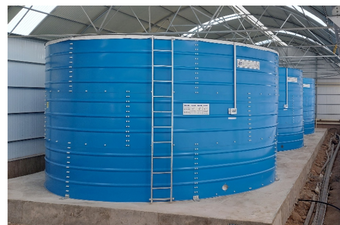
پروژه گلخانه گل سم - آبیک - قزوین - ۱۰۰ مترمکعب Project of Gol Sam's Greenhouse- Abyek - Qazvin - 100 m 3
